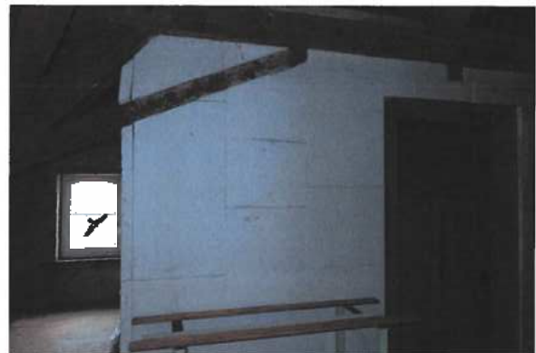
Estrichzimmer ohne Besichtigung, von aussen
