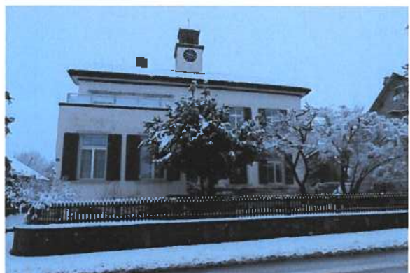
Ansicht von Westen, Flaachtalstrasse
