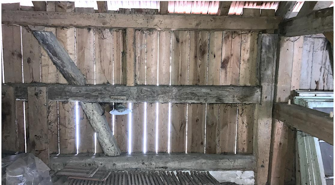
Rückseitige Aussenwand: Wandhohe Längsstrebe der bauzeitlichen Konstruktion wohl im 17. Jh.
