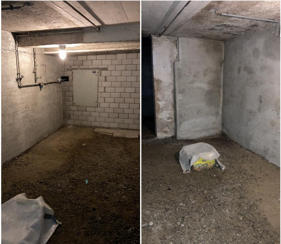
Mutmasslich beim Umbau 1961 ausgehobener oder vertiefter Keller mit um 1980 eingebautem Tankraum (KS-Zwischenwand).
