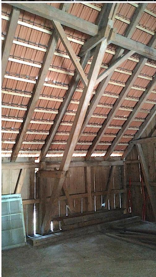
Binderebene mit Zangenkonstruktionen, die die Aussenwand an die Stuhlsäule rückbinden.
